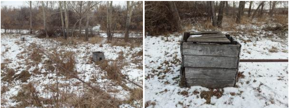
Рисунок 5 - Действующие водозаборные скважины на площадке водопроводных сооружений с. Заречье
