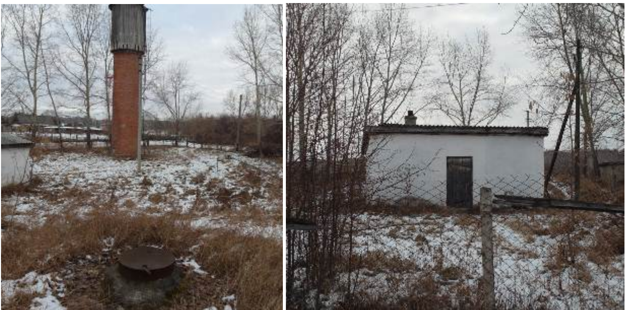
Рисунок 6 – Объекты водоснабжения на площадке водопроводных сооружений с. Заречье слева : действующий резервуар чистой воды (передний план); недействующая водонапорная башня (задний план); справа : действующая насосная станция 2-го подъема
